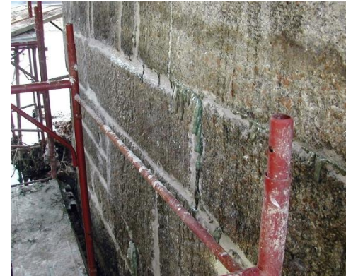
RESTABLECIMIENTO DEL CONGLOMERANTE DE MAMPOSTERÍA
