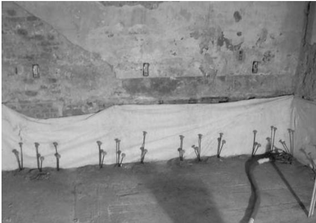
Figura 6. Tubi d'iniezione e sistema di monitoraggio.
