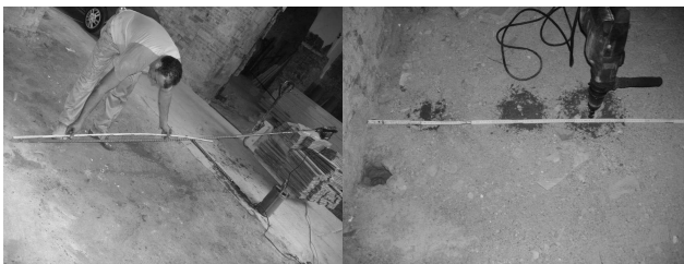
Figura 2. Indagine sulle fondazioni.
