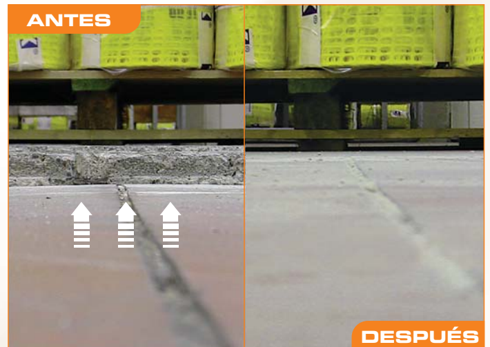
levantamiento de pavimentación industrial
