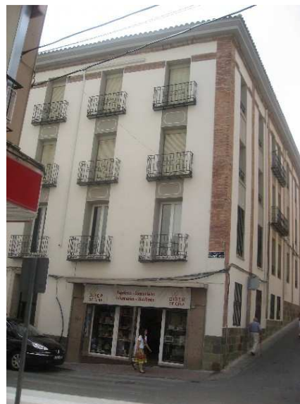
Estado Final de Obra
